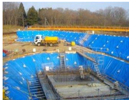
写真②: 本線Box基礎部 施工状況
